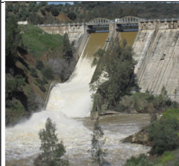
Modificación del aliviadero de la presa de Guadalmellato (CH Guadalquivir)
